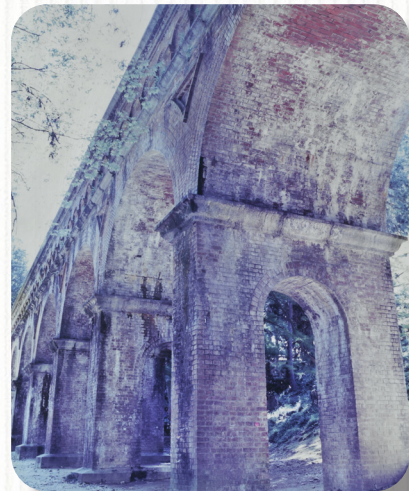
琵琶湖疎水工事に日本最初のセメントを灰孝本店より京都府へ納入する
